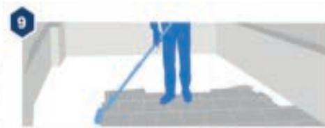
Aplique uma nova camada de TKROM ANTIGOTERAS ou TKROM CUBIERTAS para cobrir perfeitamente a malha de fibra de vidro.
